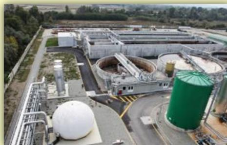
L'impianto, attivo 24 ore su 24 tutto l'anno e realizzato con nuove tecnologie, **tratta, recupera e ricicla la totalità delle acque di scarico** dello stabilimento attraverso un processo ad osmosi inversa.
